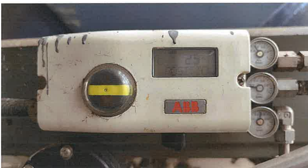
Hình 1- bộ positioner của van đầu thoát quạt gió chèn máy nghiền
