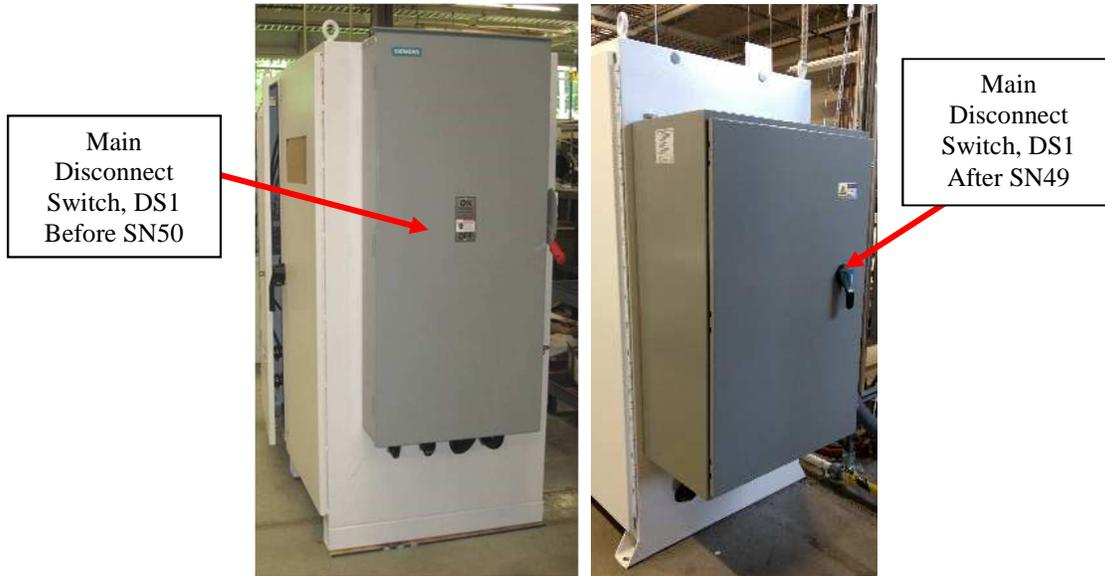
**Figure 6 - C Series main disconnect switch, DS1**
